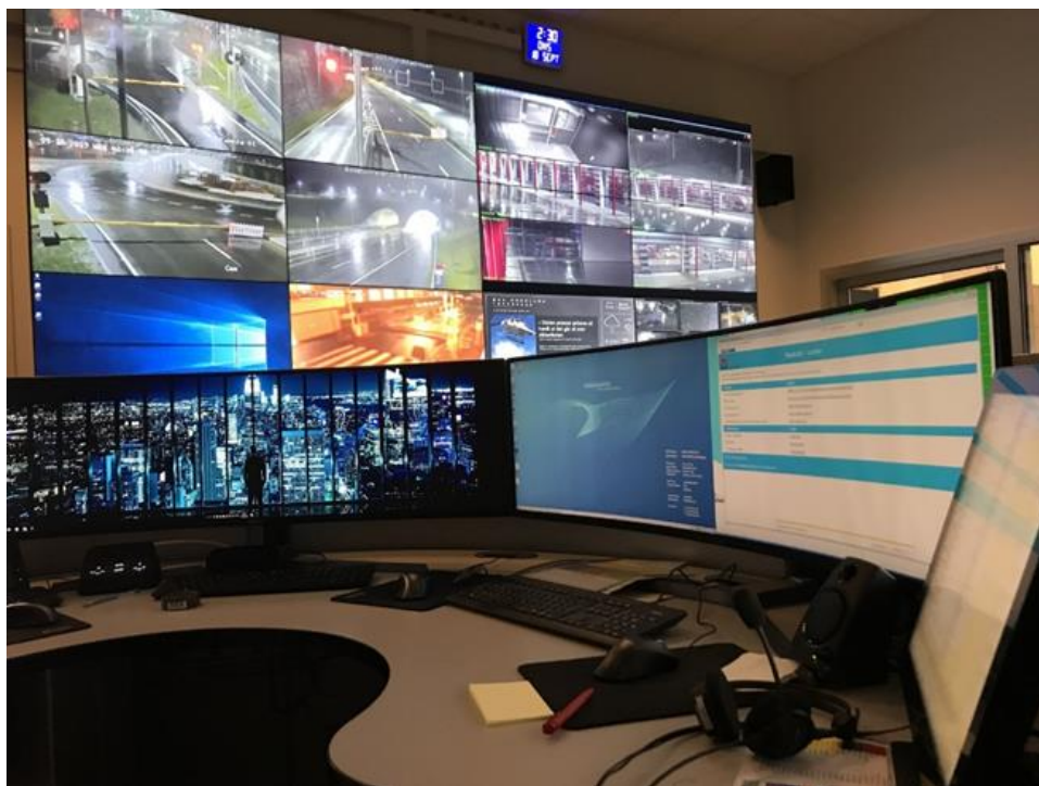
Bilde 9: 110 nødsentralen i midten av SAMLOK Nord på Albertmyra
